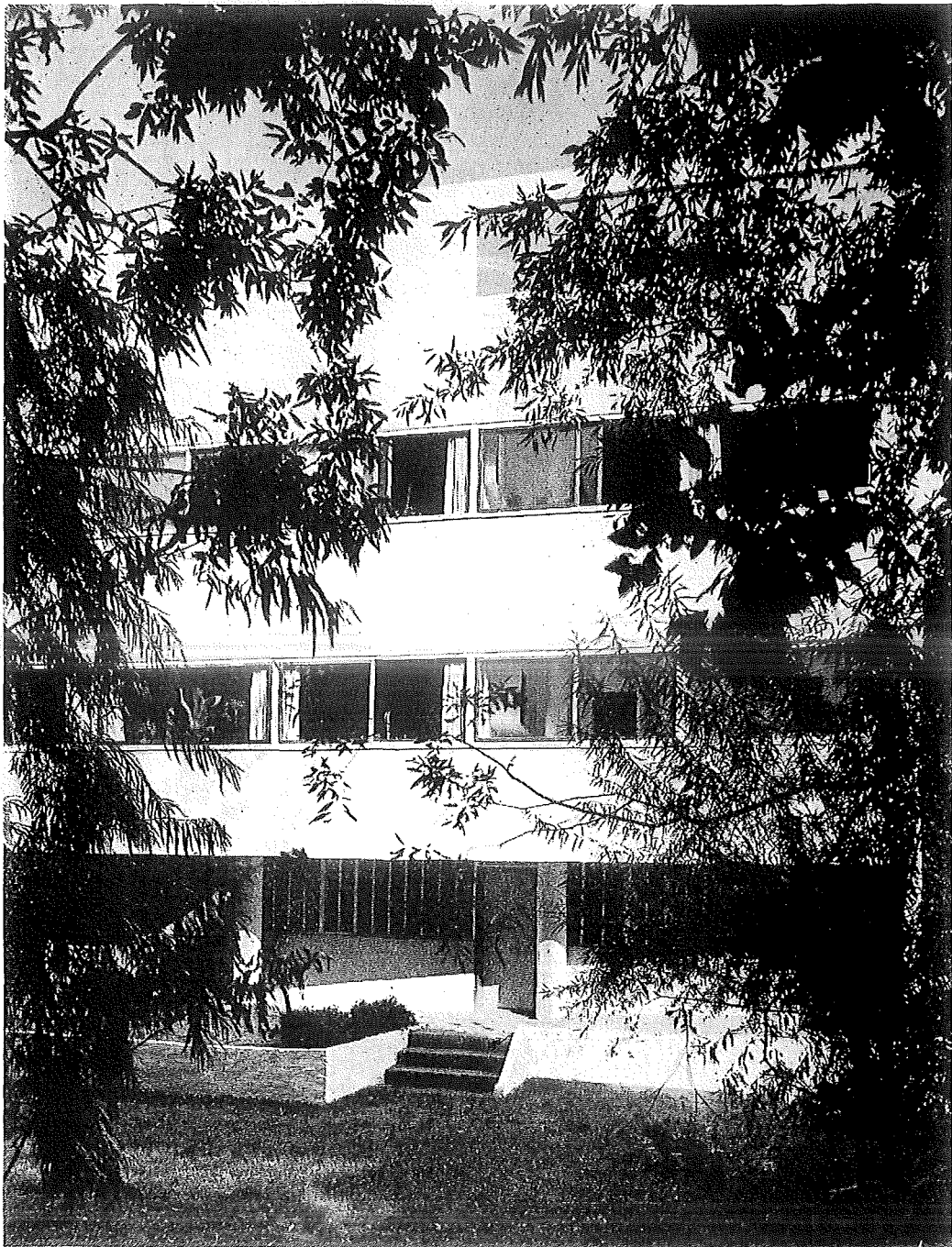
Mogens Lassen: Eget Hus i Ordrup. Façade mod Syd
